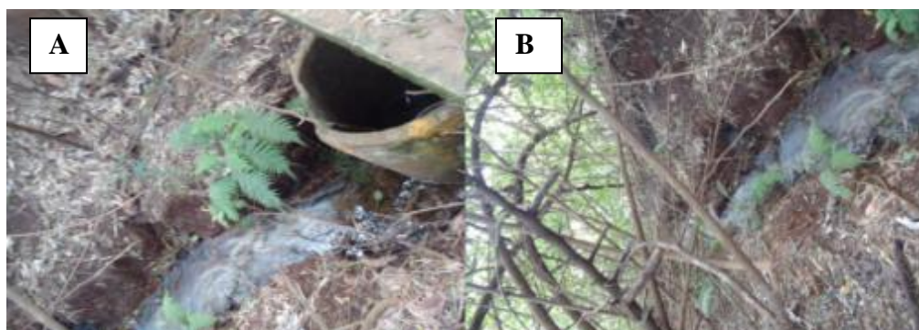
Figura 9. A) Nascente modificada pela ação humana. B) É possível constatar visualmente o assoreamento neste local. 30.06.2014. Autores: Débora Tavares Sarabia e Pâmela Souza de Paula.
