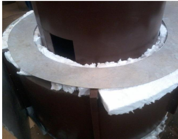
Figura 13. Processo de revestimento da estrutura do secador com isolante térmico.
