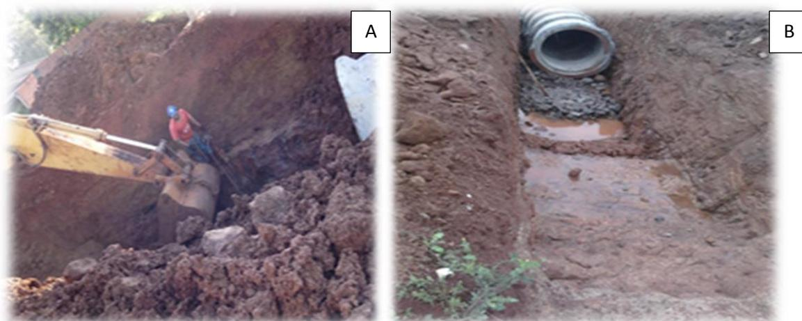
**Figura 6:** Na imagem A temos uma retro escavadeira fazendo abertura de uma vala para implantar a tubulação de drenagem e na imagem B uma parte do percurso já instalada. Autora: Mariluci Costa.
