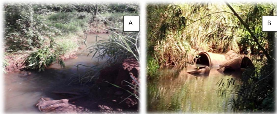
**Figura 9:** Na imagem A tem um trecho do córrego assoreado e seu estreitamento, e na imagem B, tem tubulações de drenagem de águas pluvial que caíram no córrego; Autor: João Gonçalves.
